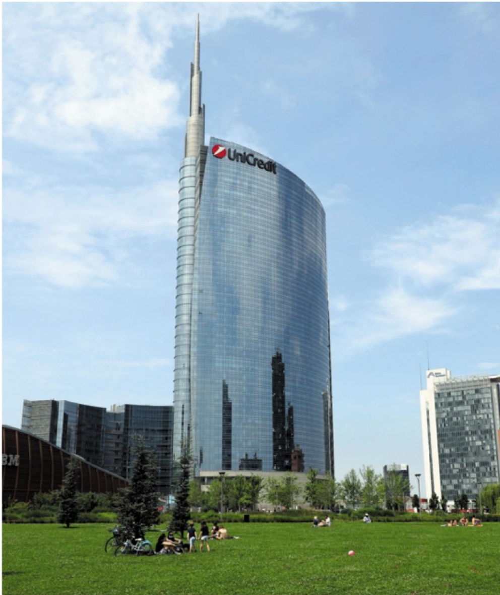
L'Unicredit Tower a Milano ANSA
