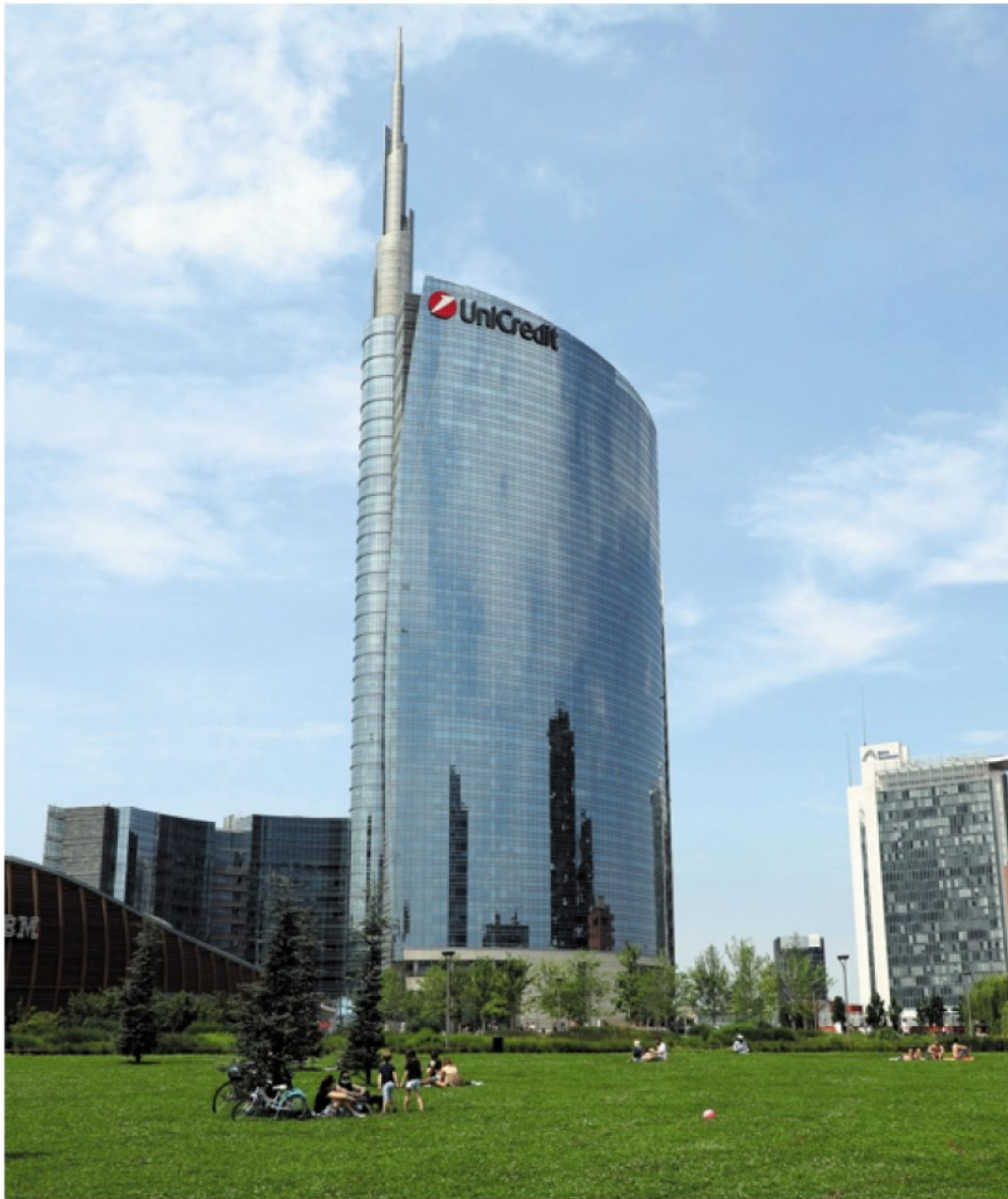
L'Unicredit Tower a Milano ANSA
