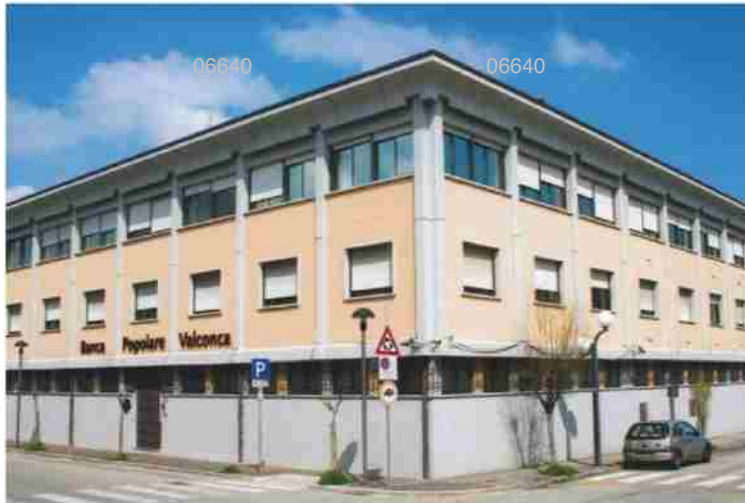
La sede centrale della Bpv a Morciano
